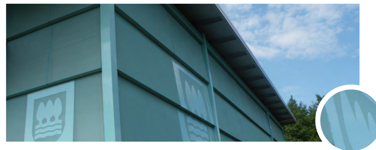
> Imagen Patrón > Fachada con Rótulo
